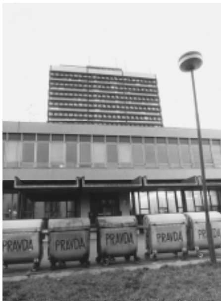
Budova presscentra v Bratislave – pred rokom 1989 sídlo redakcií všetkých slovenských novín.
